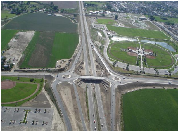
지역 3 24 도로 교차로의 I- 70 신규 교량 및 두 개의 로터리
