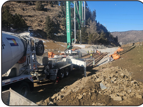
Image 6. Concrete Pour for CP #3
