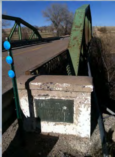
Purgatoire River Bridge, 2014
