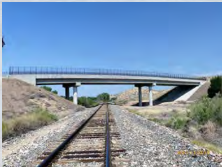
K-16-CI (Rio Grande Viaduct)
