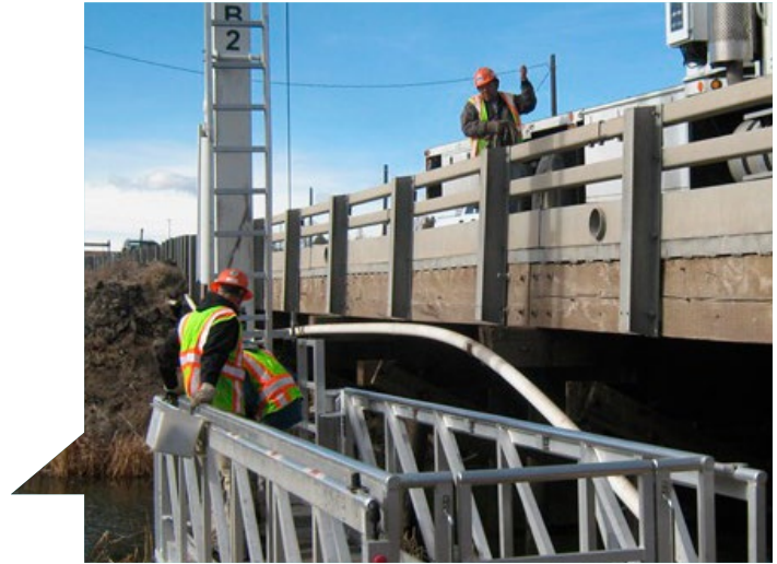
Cuadrilla de trabajadores reparando el puente. Fuente: CDOT, 2020
