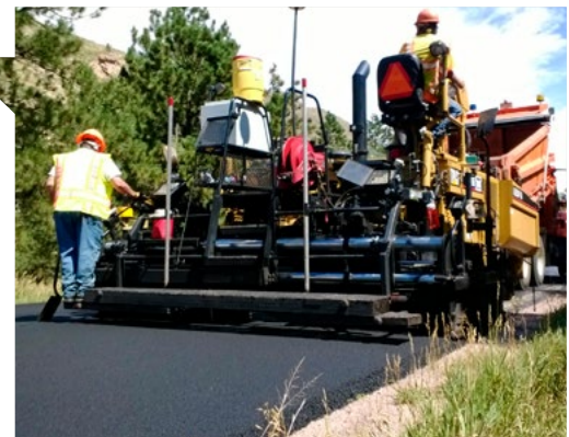
Cuadrilla de trabajadores en la pavimentación rural Fuente: CDOT, 2020
