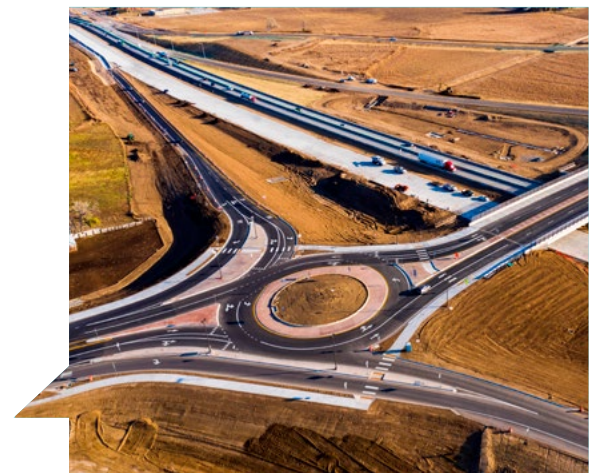
Construcción en la Interestatal 25 Fuente: CDOT, 2020
