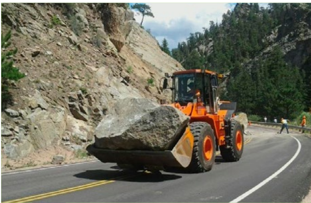
Cuadrilla de trabajadores retirando escombros de rocas en la Carretera Estatal 119 Fuente: CDOT, 2020
