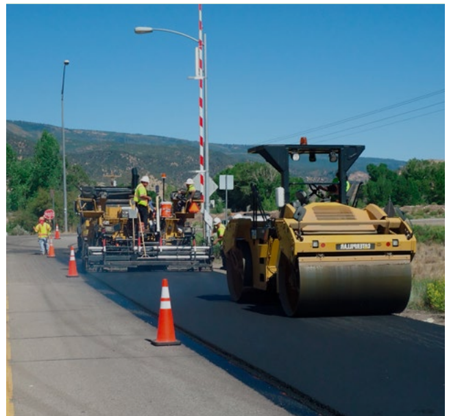
Cuadrilla de trabajadores repavimentando y realizando otras mejoras de seguridad Fuente: CDOT
