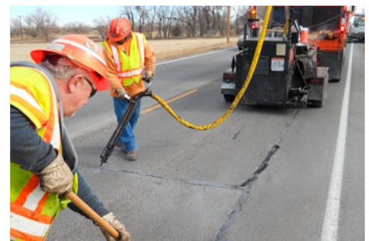
Cuadrilla sellando las grietas de la Carretera 7 Fuente: CDOT, 2020
