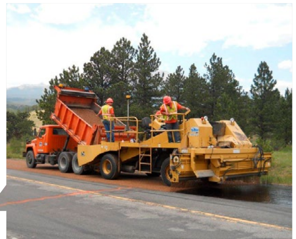
Cuadrilla trabajando en la Carretera Estatal 7 Fuente: CDOT, 2020
