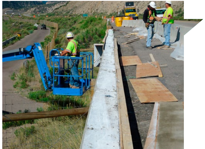
Cuadrilla de trabajadores en la obra de construcción de barreras de protección Fuente: CDOT, 2020
