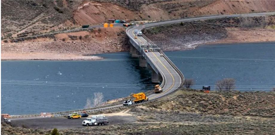
El puente Blue Mesa de la US 50 se cerró entre el punto kilométrico 136 y el punto kilométrico 140 en abril de 2024 por motivos de seguridad derivados de una grieta en el acero de alta resistencia. Las reparaciones se llevaron a cabo por fases.
