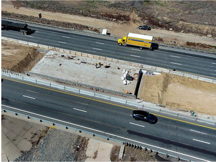
Carriles Express de la I-25 Norte: Tramos 6, 7 y 8. Incluyendo New Bridge Deck Valley Road, Berthoud.
