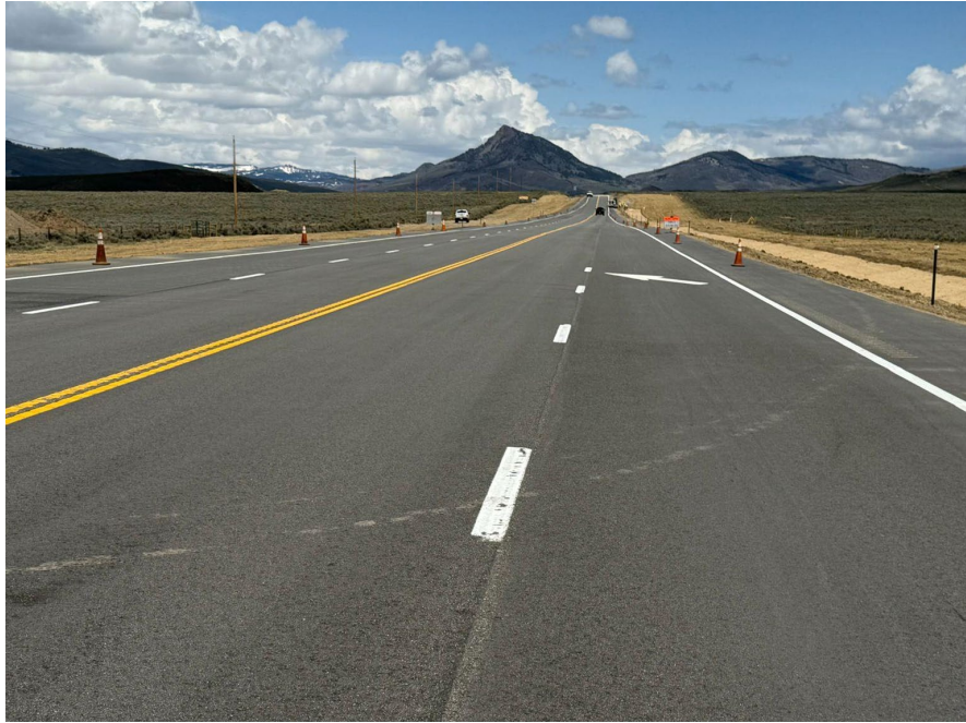
Carriles de adelantamiento de la US 40 alrededor de Kremmling
