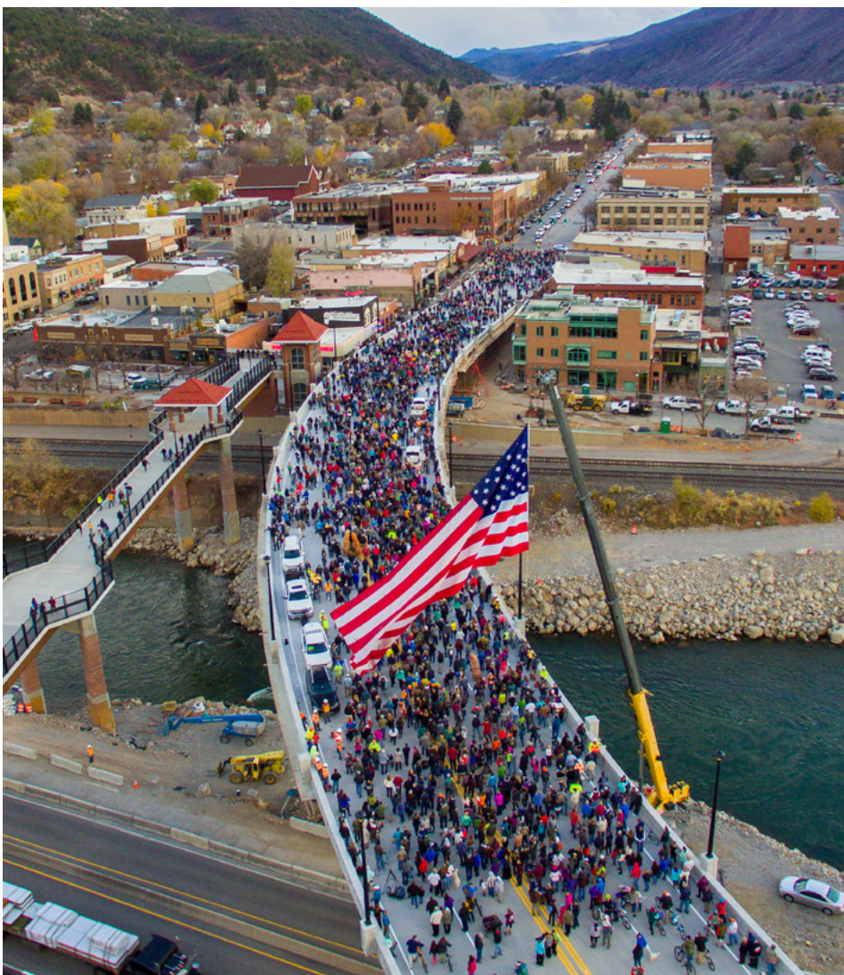
Ceremonia de corte de cinta del Puente de Grand Avenue en Glenwood Springs
