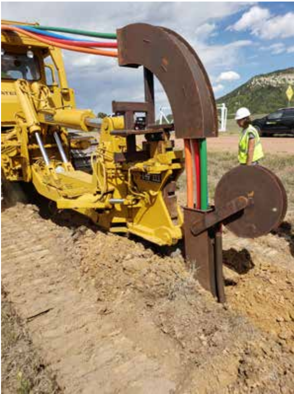
Crews plow fiber optic conduit.
