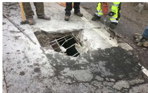
Falla en la cubierta del puente en la I-270 sobre el Canal de Burlington
