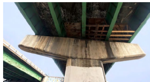
Deterioro de las condiciones del puente en la I-270 sobre Brighton Boulevard
