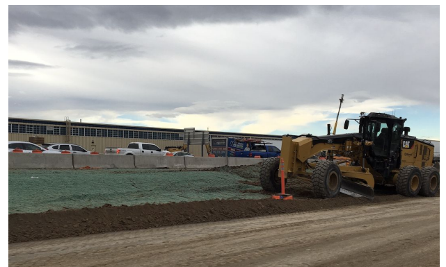
Cubierta de tierra a lo largo de Stapleton North Drive, diciembre 2019
