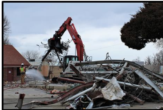
Los equipos de construcción rocían agua en el lugar de la demolición del Motel Colonial Manor
