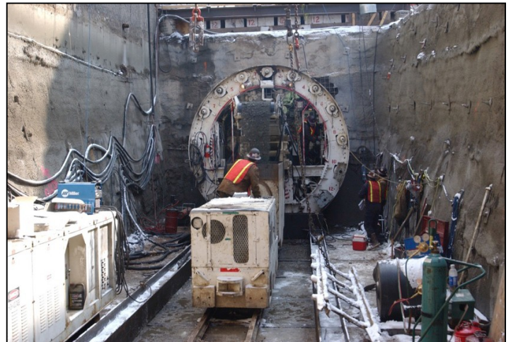
Tuberías de alcantarillado de la I 25 Sur. El sistema del Central 70 se construirá para aguantar tormentas que ocurren cada 100 años; similar a la I 25.
