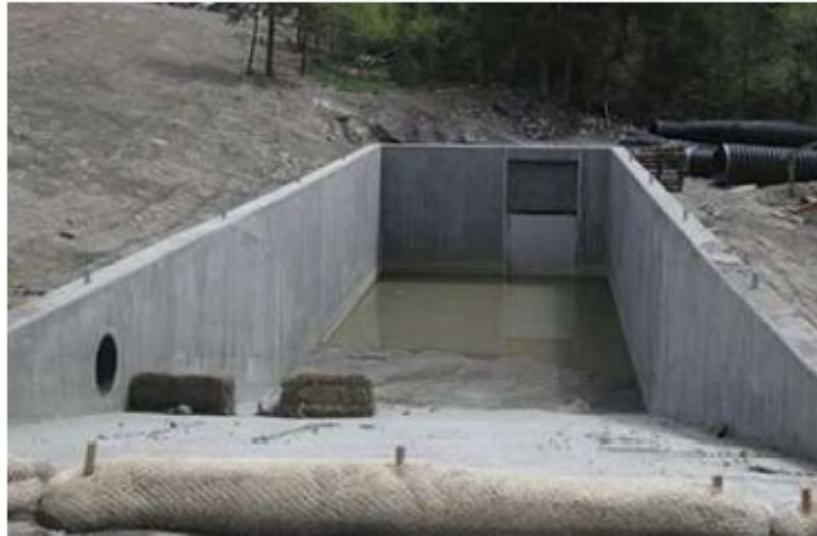
Figure 3.4. Loading Dock Trap (Berthoud Pass East)
