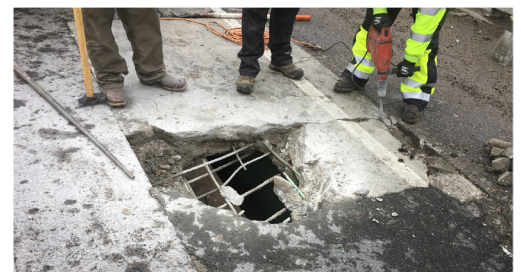
Falla en la cubierta del puente en la I-270 sobre el canal de Burlington
