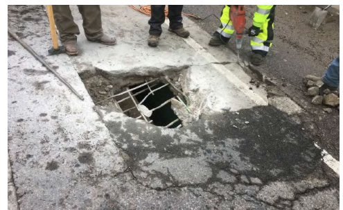
Falla en la cubierta del puente en la I-270 sobre el Canal de Burlington
